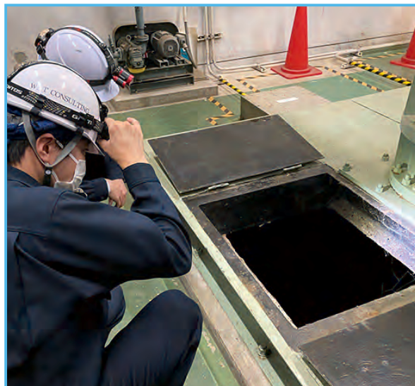
▲小さな開口部から ドローンを入れて点検(幅300mm以上)
