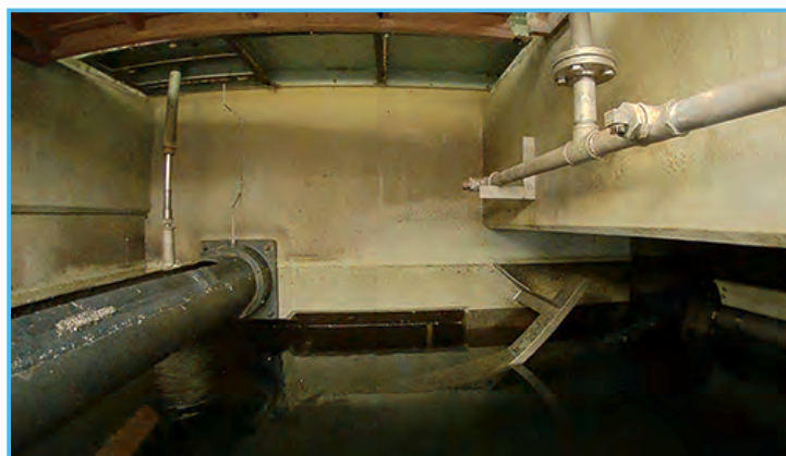
▲小さな開口部から ドローンを入れて点検(幅300mm以上)
